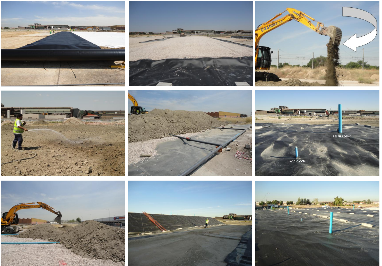
Fotografías correspondientes a la descontaminación de 54.000 \text{ m}^3 de suelos con aceites hidráulicos y fuel oil, en una antigua parcela industrial en Madrid.
