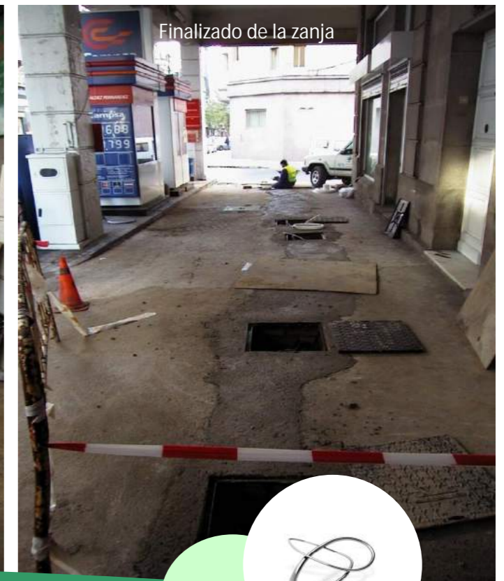
Hormigonado de las zanjas
