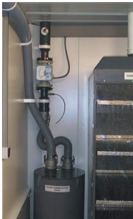
Foto 11. Filtro carbón activo gases y rotámetro
