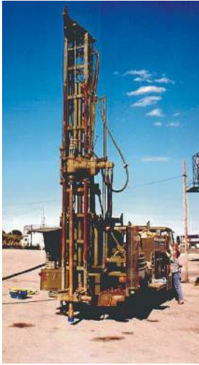
Foto 2. Máquina de sondeos realizando un sondeo de gran diámetro a tricono
